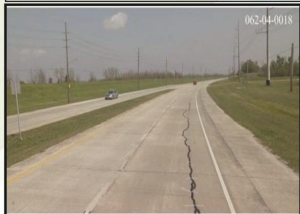
ویننه (۵)، دروست بوونی درزی هره مه کی به هو ی نه بوونی (longitudinal joint)
