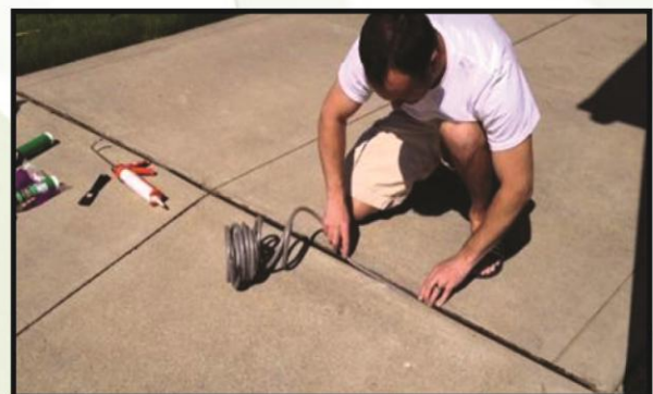
وینهی (۸) پر کردنه وهی (expansion joint)
